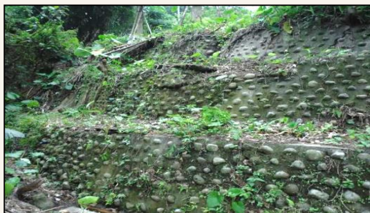
文舍旁邊坡現況
