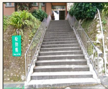
松勁樓前樓梯 (安裝止滑條)
