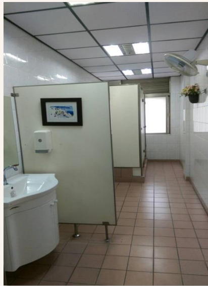
二樓男廁現況
