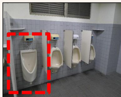
綜合大樓、一教研 小便斗 (安裝扶手)
