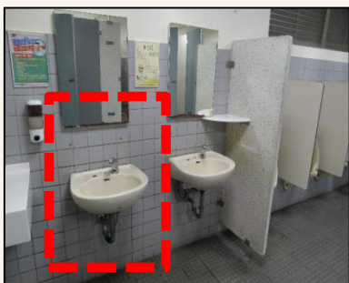
綜合大樓、一教研洗手台 (安裝扶手)
