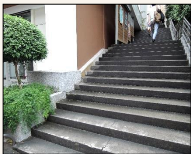
圖書館西側樓梯 (安裝扶手、止滑條)
